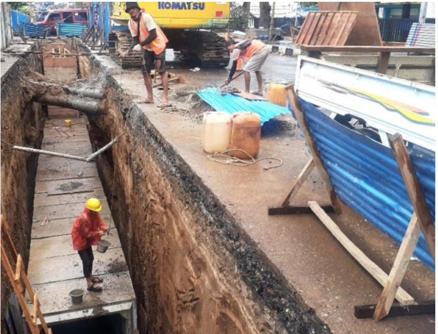
Pekerjaan Drainase Kota Bukittinggi kini telah mencapai 70%
